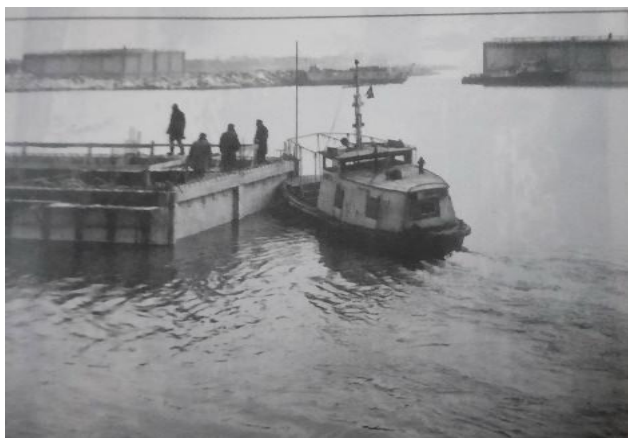
Слика 5 – Монтажа кесона
